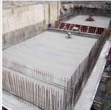
Einbau Bodenplatte neue Beckenkammer
