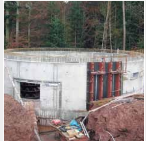
RÜB Zulaufseite im Bauzustand
