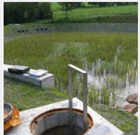
Fertiggestelltes Becken mit Retentionsbodenfilter
