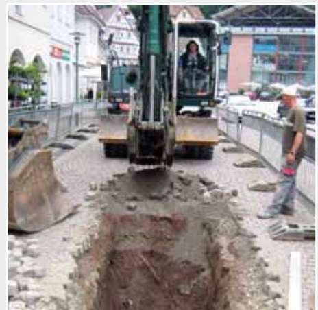
Grabenaushub vor Haus Schnaufer
