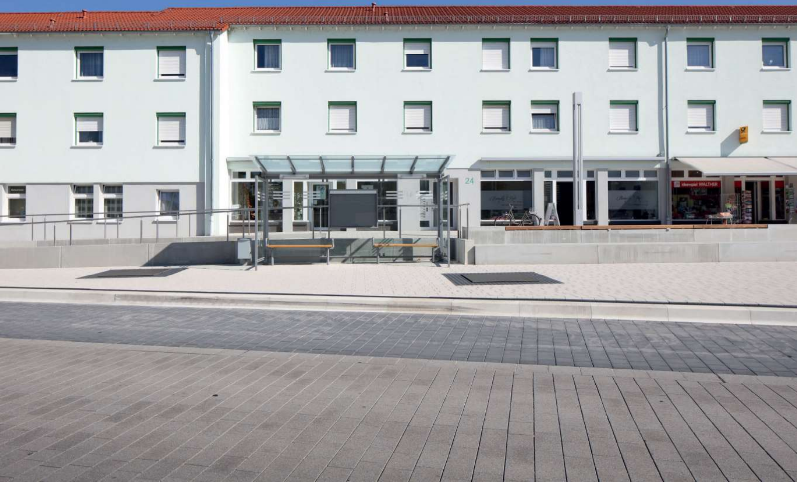
Barrierefrei und konsequent funktional: Die neu geschaffenen Bushaltestellen im Norden der neuen Mitte Amorbachs
